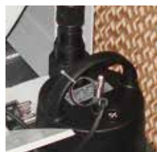
BOMBA DE AGUA GRUNDFOS CON REGULACIÓN DE CAUDAL Y SISTEMA DE DRENAJE CONTINUO PARA EVITAR LA CONCENTRACIÓN DE SALES MINERALES.
