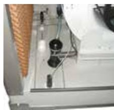
REGULACIÓN DE CAUDAL DE AGUA Y SISTEMA DE DRENAJE CONTINUO, PARA EVITAR LA CONCENTRACIÓN DE SALES MINERALES.
